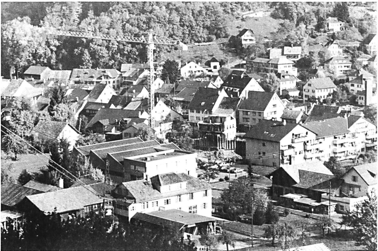
Rund um den Dorfkern herum sind Neubauten entstanden, wobei auch hier da und dort alte Bausubstanz gepflegt worden ist.
