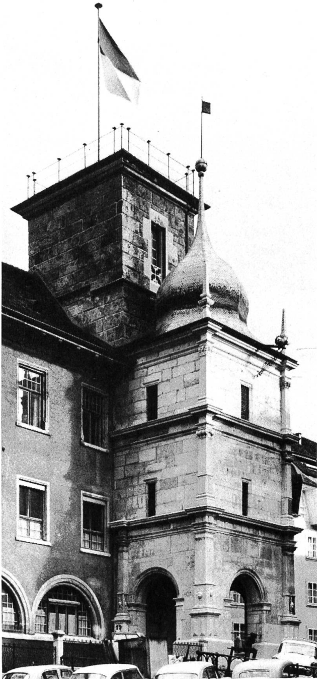
4 Solothurn, Rathaus, der Archivturm von 1623/24. Ansicht von Südwesten. Foto: Ernst Räss †, Solothurn 1963.
