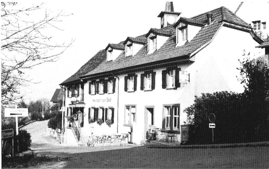
Restaurant Bad mit den heute noch erwünschten Dachaufbauten.
