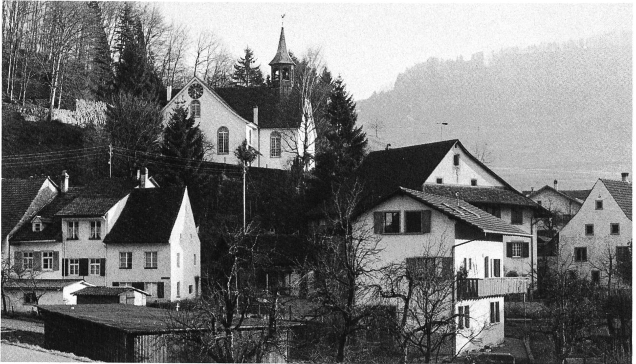
Die Kirche von Buus 1982. Foto: Dr. Heyer, Kant. Denkmalpflege Liestal.
