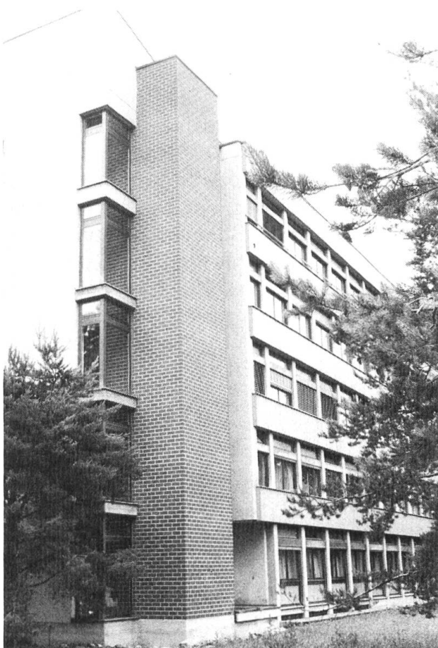
Verwaltungsgebäude an der Wahlenstrasse von 1970/71 von Südosten gesehen.
