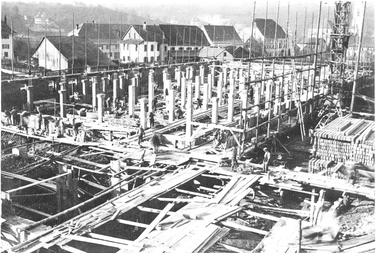
Werk 3, in Bau 1924, mit teilweiser Überdeckung des Birskanals.
