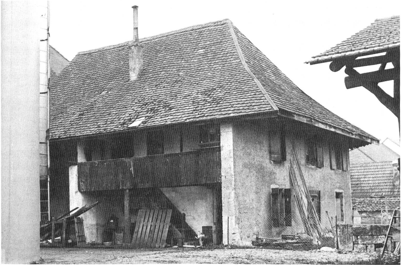
1 Das «Gerichtsstöckli» von Nordosten, Zustand 1985.
