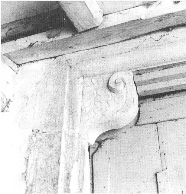
2 Zierformen am Gewände der Kellertür nach Westen, wahrscheinlich von 1627.
