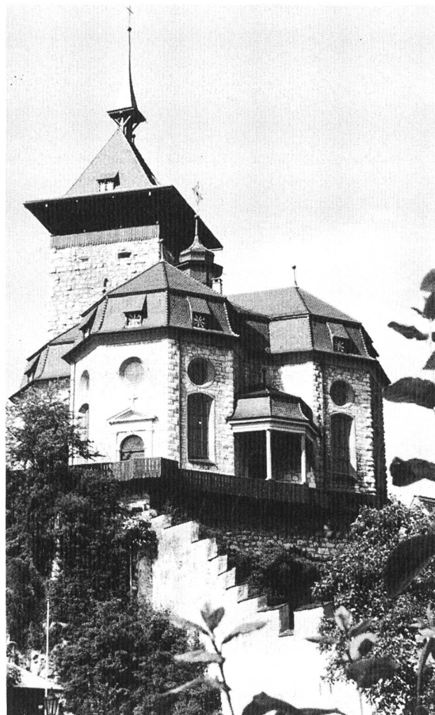
Schlosskirche Niedergösgen vor der Restaurierung. Foto: Architekturbüro A. + M. Mercatali, Niedergösgen/Denkmalpflege Solothurn
