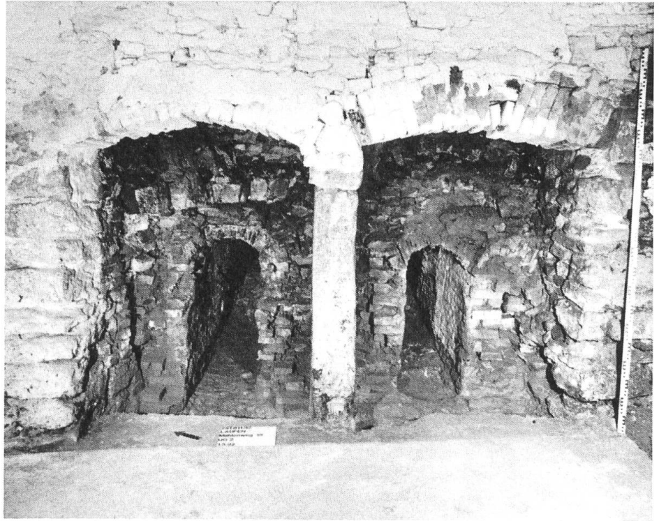
Abb. 6: Die Einfierungsöffnung des Ofens 2.
