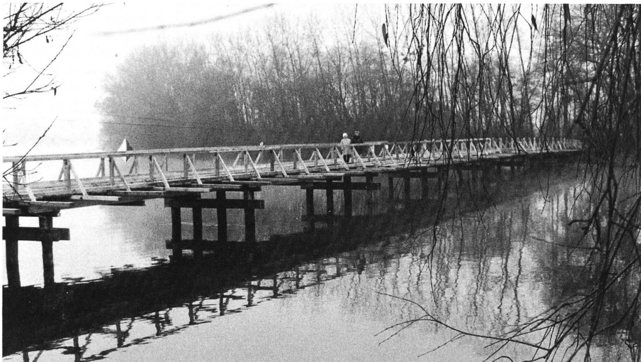
Im Winter 1991/92 wurde auf dem Inseli eine Hofsanierung vorgenommen. Für diesen Umbau hat das Genie Bat 22 innerhalb der Aktion «Gemeinsam» vorübergehend eine Holzbrücke erstellt.
