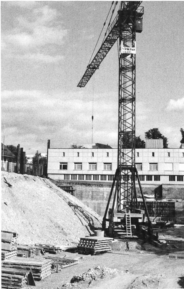
Der 5geschossige Archivbau wird erweitert: Baustelle Staatsarchiv von Westen am 3. Oktober 1991.
