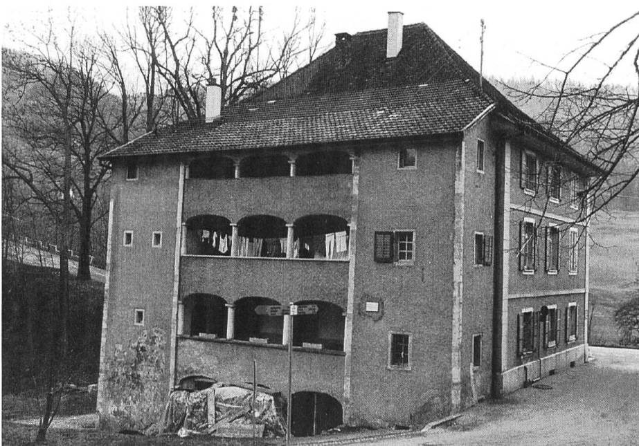
Neuhüsli, Nordseite. Foto U. Wiesli.
