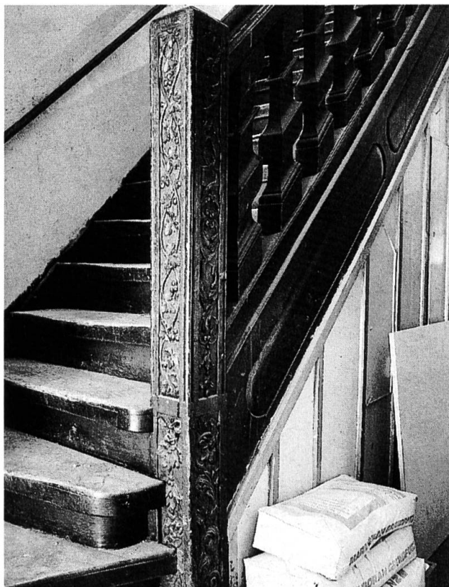
4 Antrittsposten der barocken Treppe.
