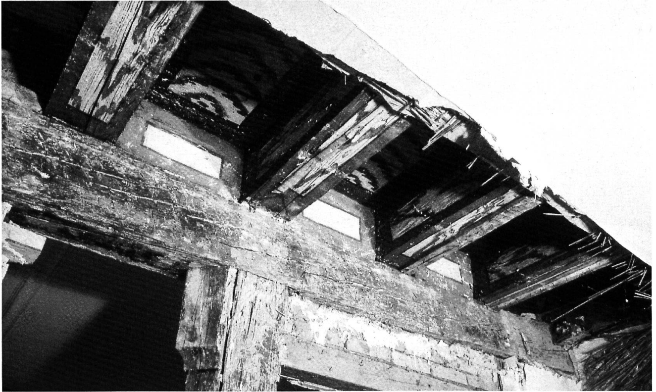
9 Freigelegte bemalte Holzdecke im 3. Obergeschoss.
