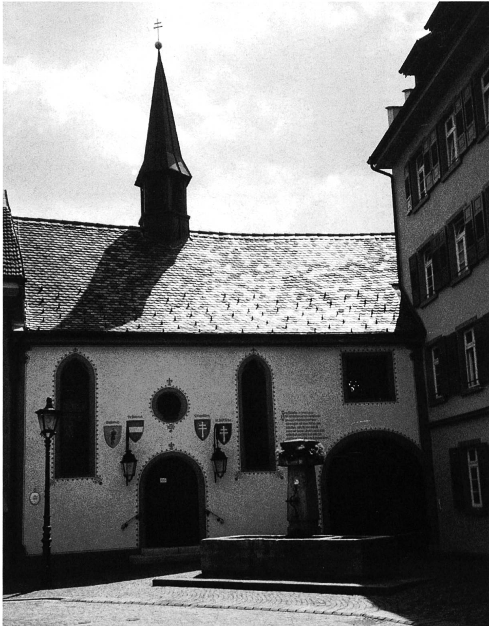
Aussenansicht der Spitalkapelle. Die Heiliggeistkapelle in Waldshut wurde in jahrelanger Kleinarbeit von einer Rumpelkammer zu einem liebevoll und sorgfältig renovierten Baudenkmal.
