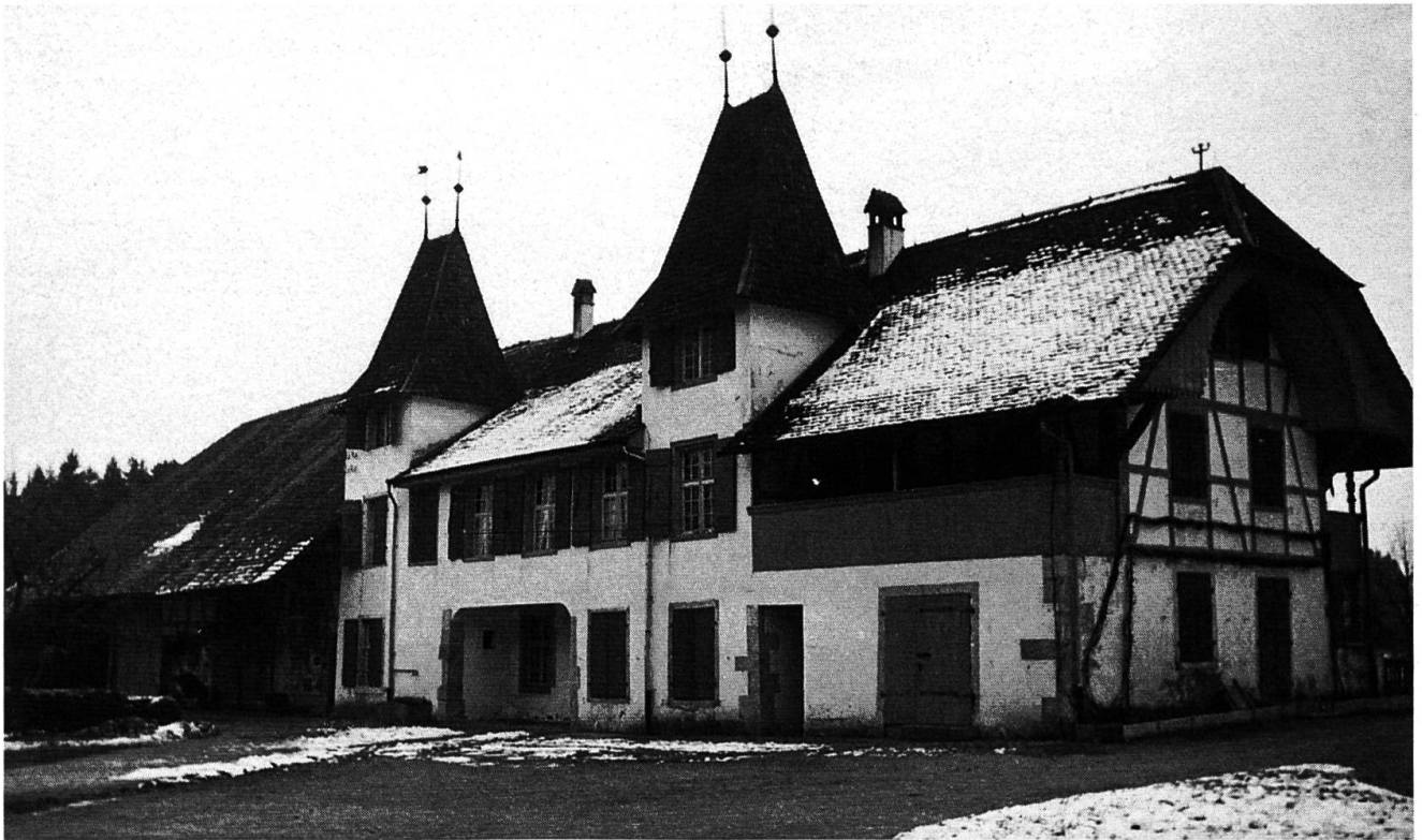
Der Buchhof in Lohn/Ammannsegg. Aufnahme 1951. Archiv Denkmalpflege.
