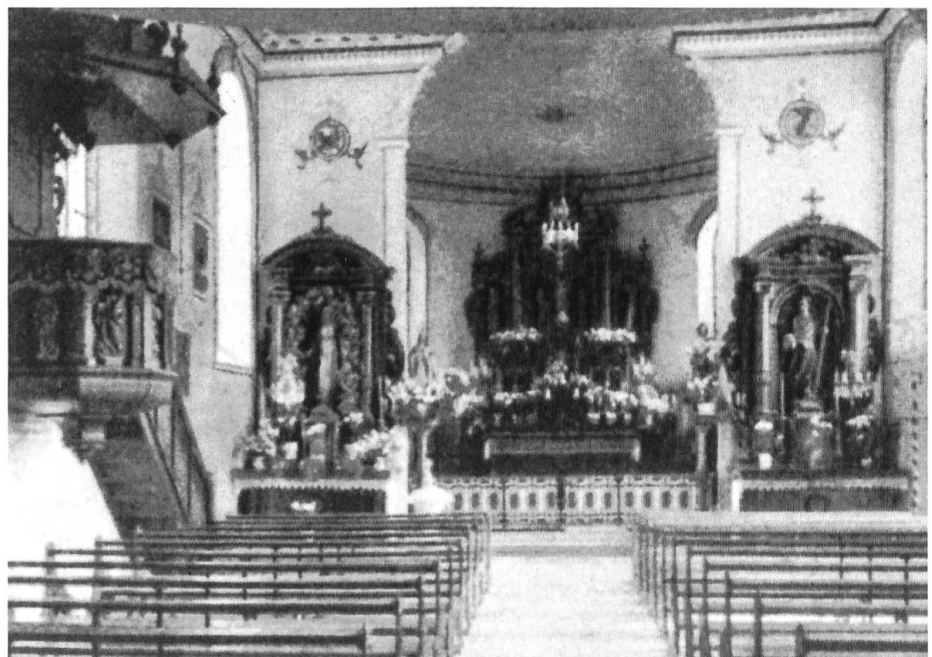
Inneres der Dorfkirche vor der Renovation von 1953.
