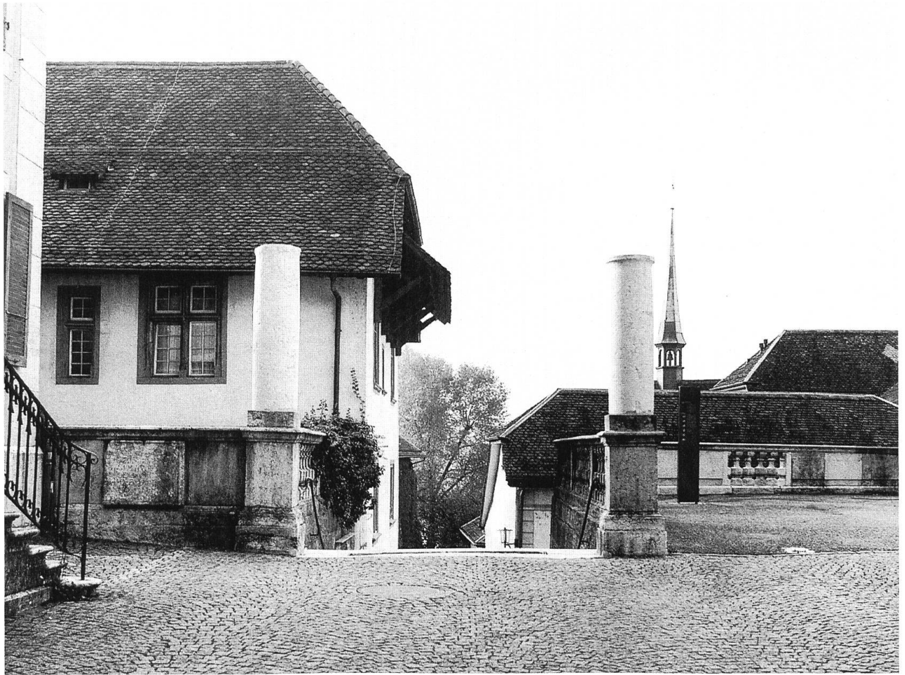
④ Die wieder aufgestellten «Hermessäulen» bei der Katzenstiege, 1997. Foto: Kant. Denkmalpflege.
