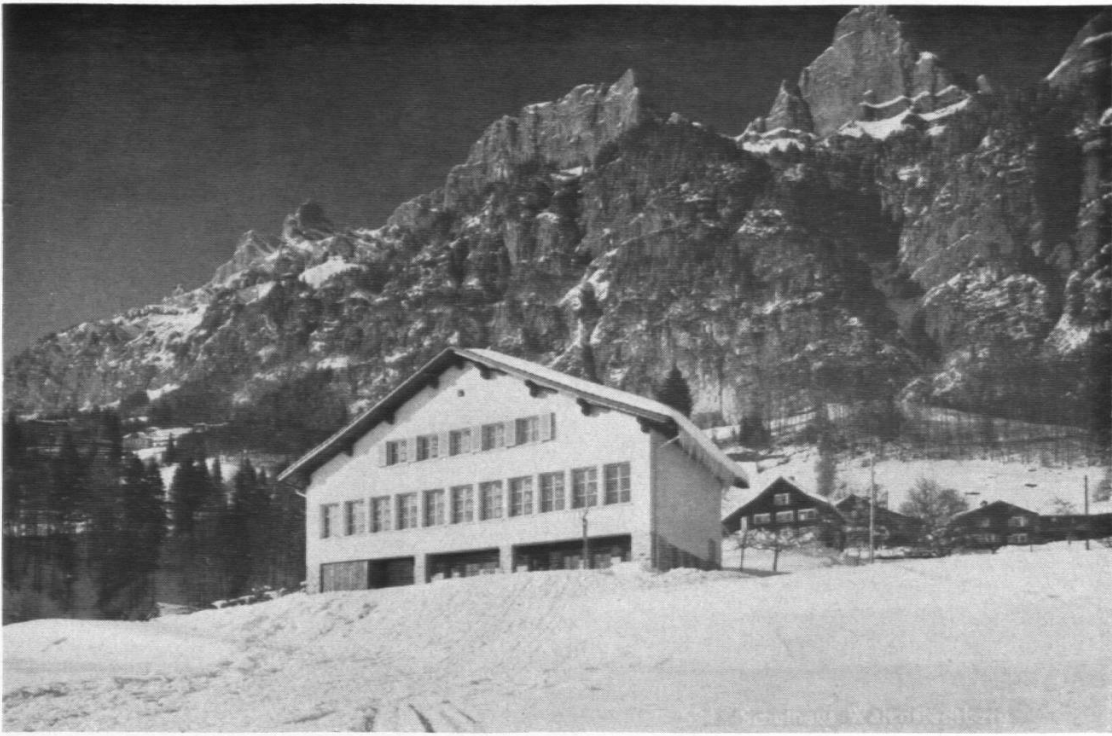
Walenstadtberg Architekt Camenzind, Sargans
