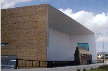
11. Münchenstein, Schulager für die Emanuel Hoffmann-Stiftung: Der kleine Portikus unter dem hochliegenden Dachvorsprung vermittelt zur Umgebung.
