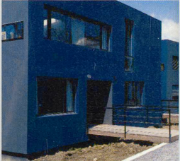
9. Luzern, Doppelhäuser Dreilindenstrasse: Intelligente Bezugnahme zum KKL Luzern mit Farbigkeit, Fensteranordnung und Erschliessungsstegen.
