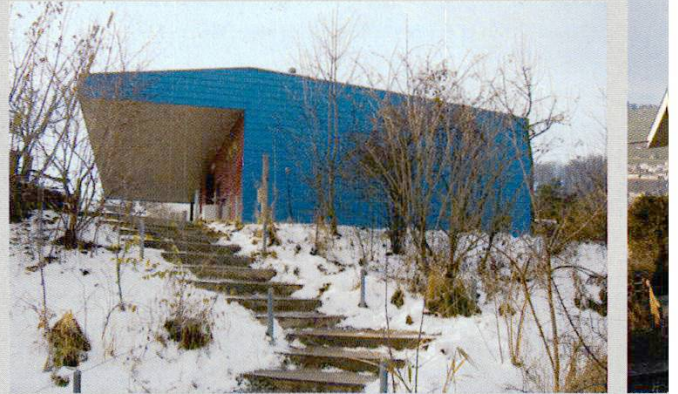
3. Zürich, Kinderzoo Zoolino: Die Untersichten der ausragenden Vordächer sind mit Alufarbe gestrichen.
