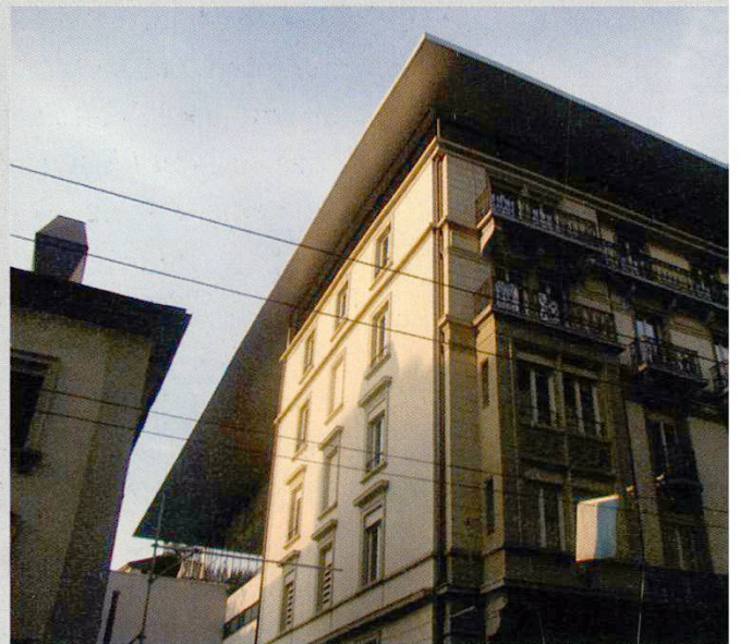
5. Luzern, Fitnesspark National: Das ausladende Dach vereint Alt- und Neubau.
