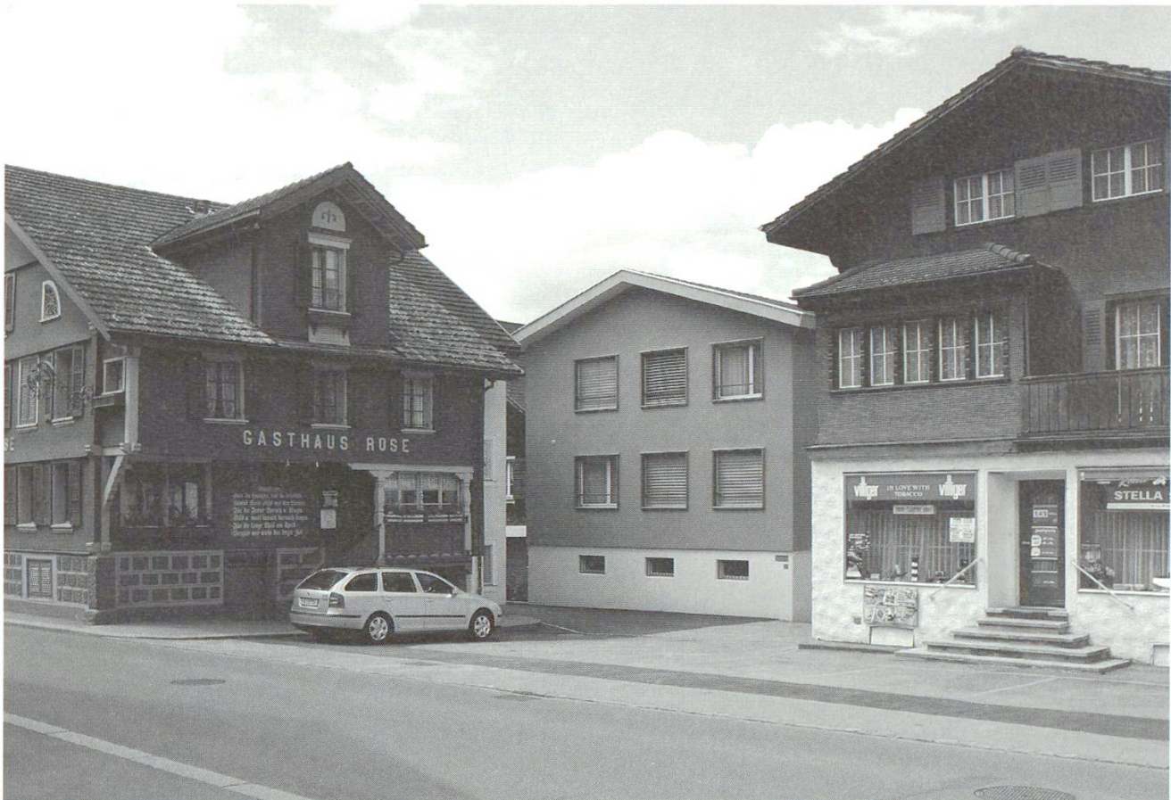
2005 entstand mitten in Kerns ein qualittsvoller Neubau an der Stelle eines historischen Vorgngerbaus. (Foto PD)
