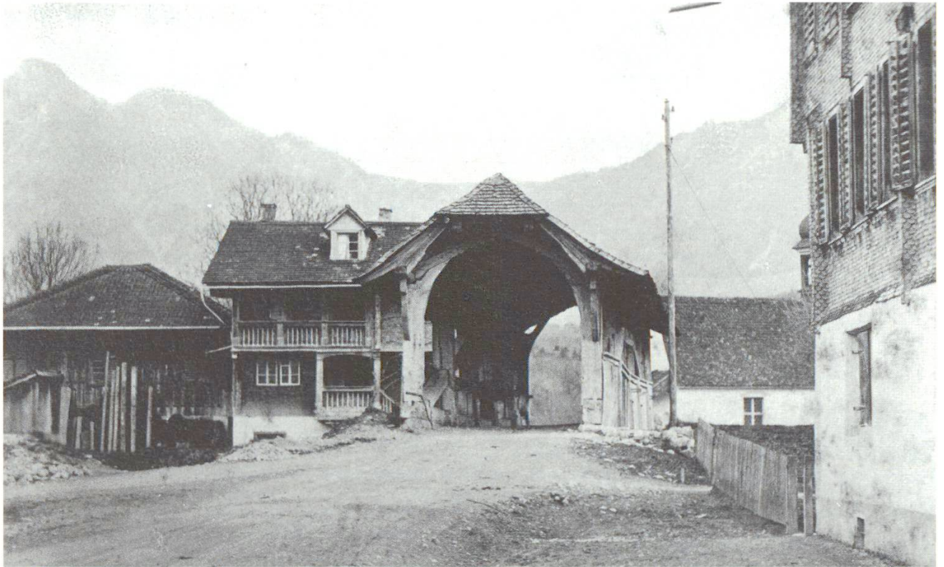
Die Holzbrücke über die noch nicht umgeleitete Melchaa stand ungefähr beim heutigen Bahnübergang, Richtung St. Antoniuskapelle Sarnen. Sie musste dem Bau der Eisenbahn weichen. (Foto zVg)
