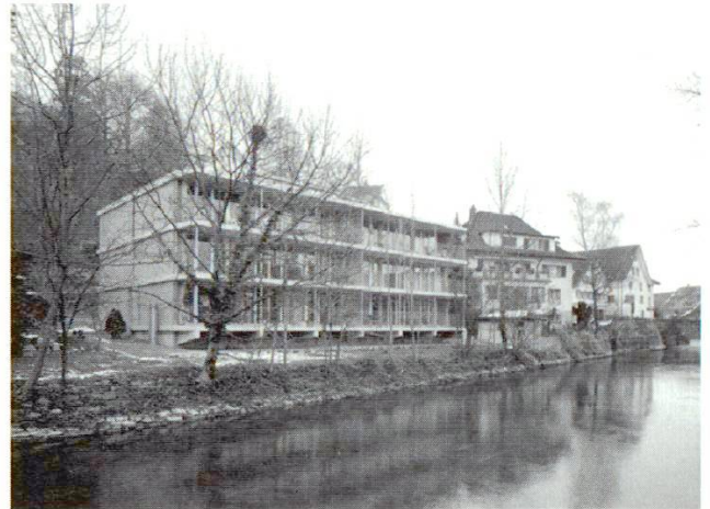
Mehrfamilienhaus Kirchstrasse, Sarnen
