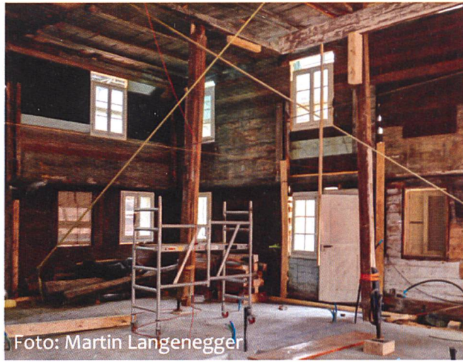
Sanierung MFH in Rothenburg
