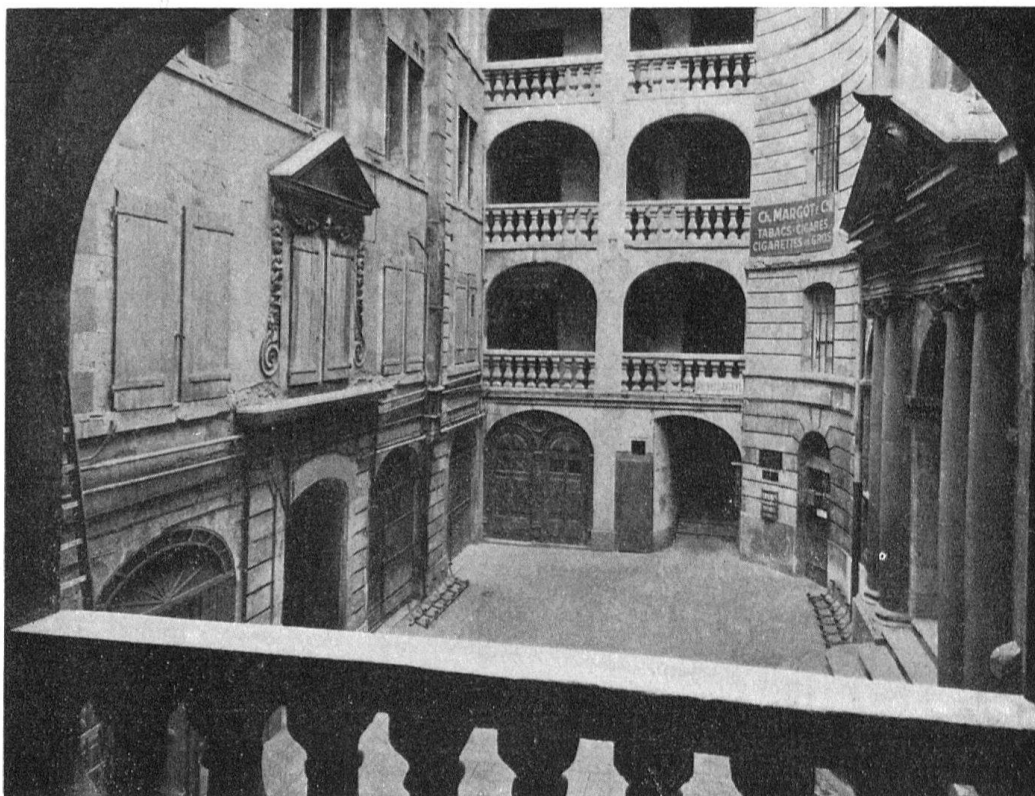
Ancienne maison Bonnet à Genève. La cour avec l'escalier
