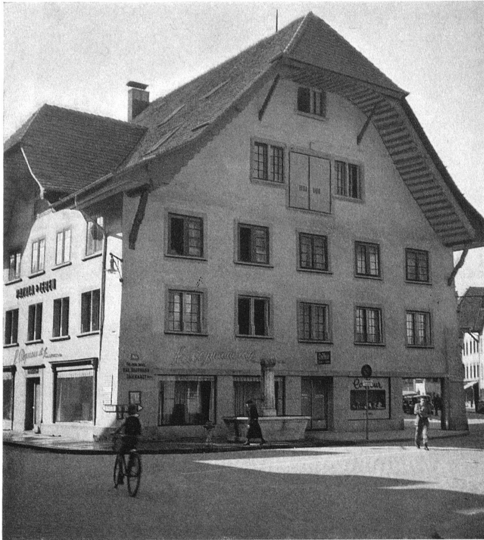
Aarau, das Saxerhaus vor der Wiederherstellung
