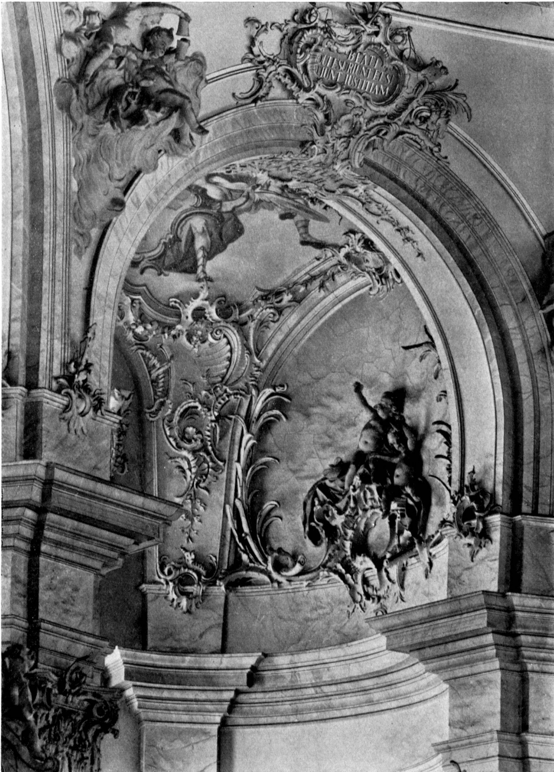
St. Gallen, Stiftskirche. Blick in das Gewölbe des Rotundenumganges
