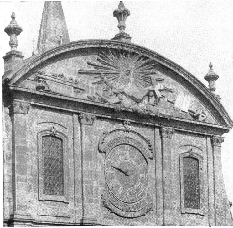
Tympan de l'église d'Yverdon. Etat en 1912, avant les restaurations
