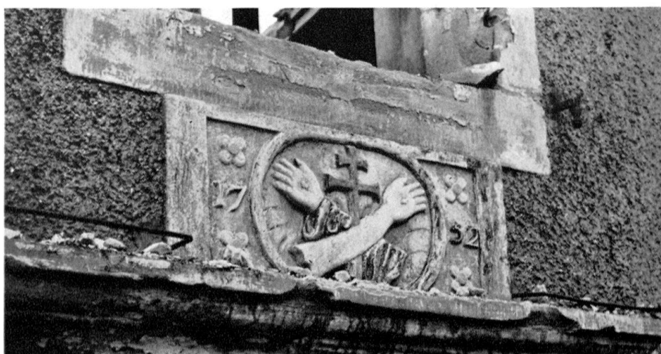
La Cure de Font pendant la démolition: Relief daté 1752, aux armes des Cordeliers, au-dessus de la porte
