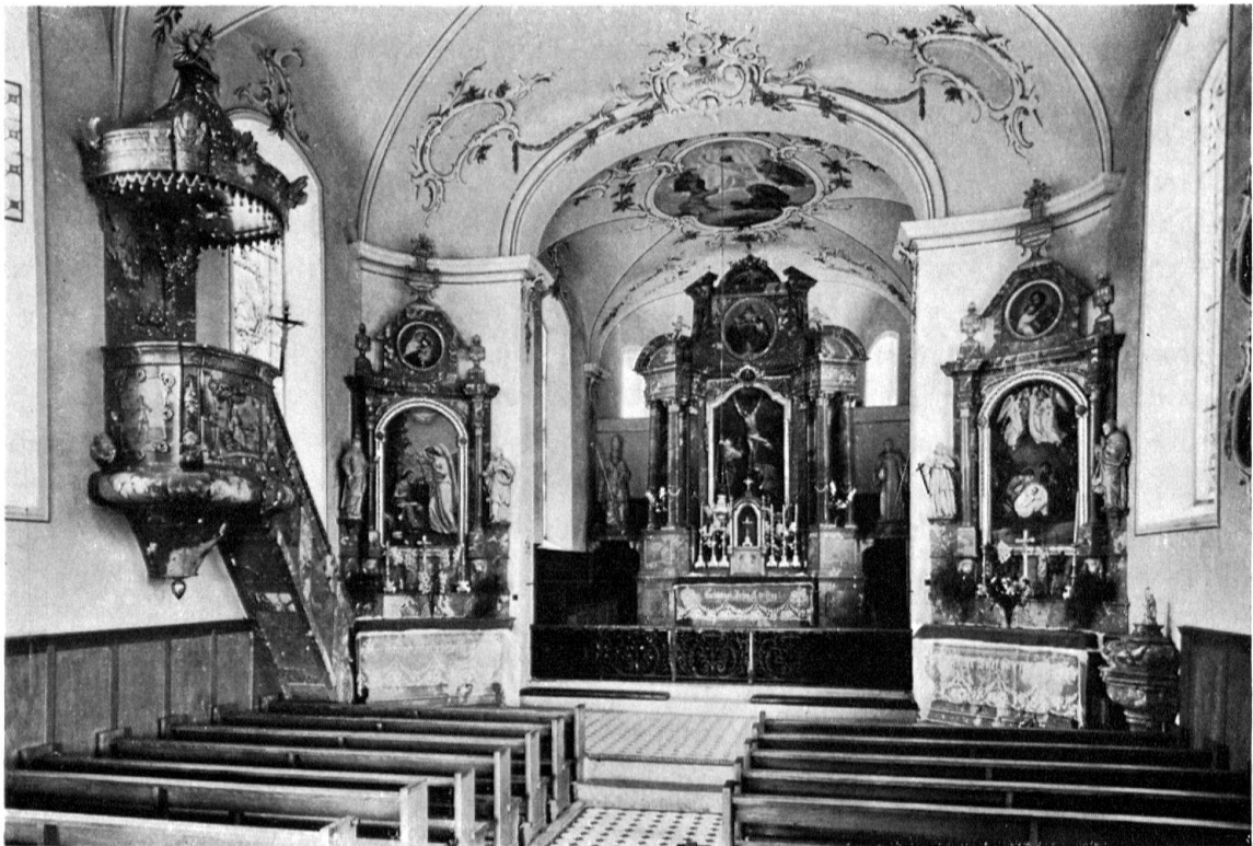
Abb. 1. Pfarrkirche von Bettwil AG, errichtet 1789
