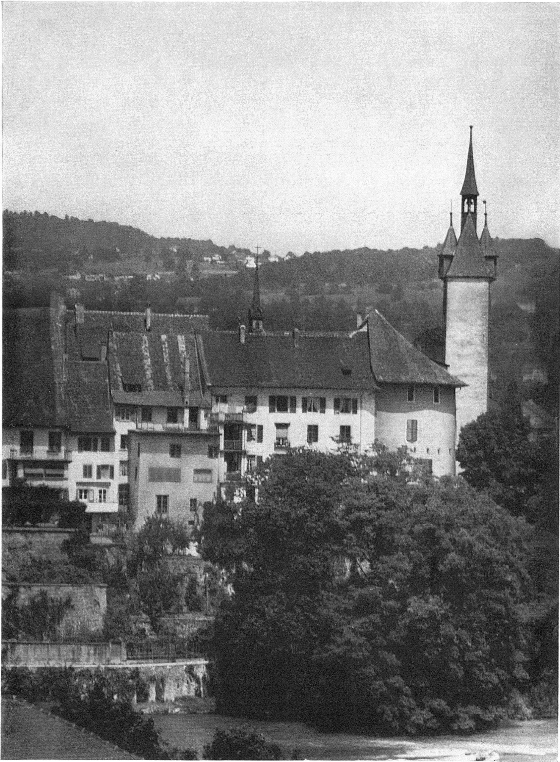
Bremgarten. Blick von Süden mit Spittelturm
