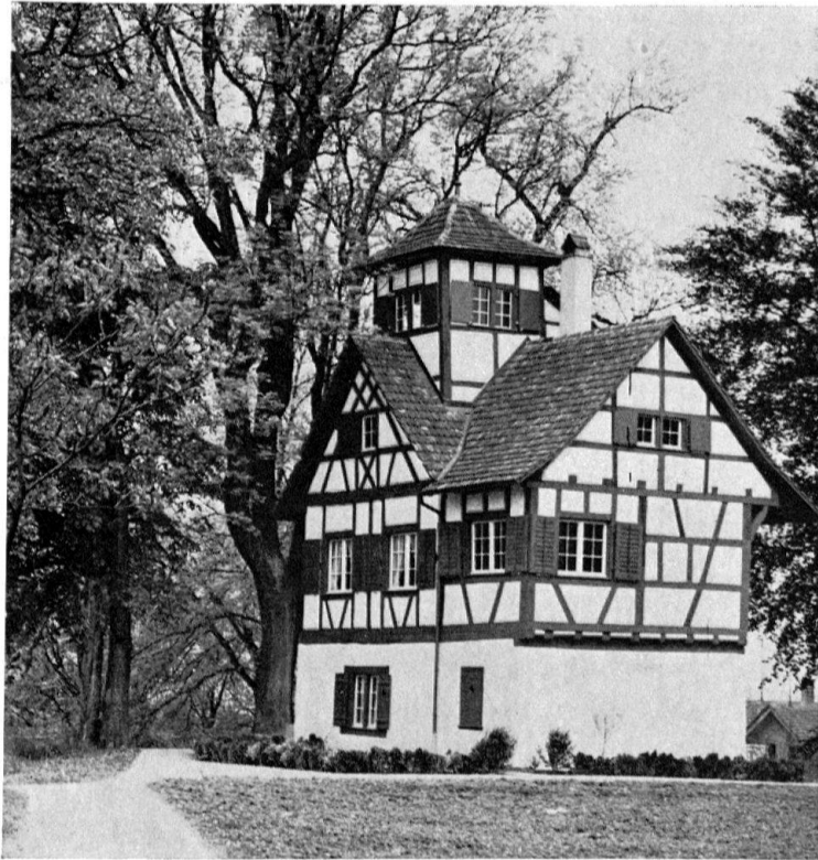
«Guggenhürli», Frauenfeld. Nach der Restauration
