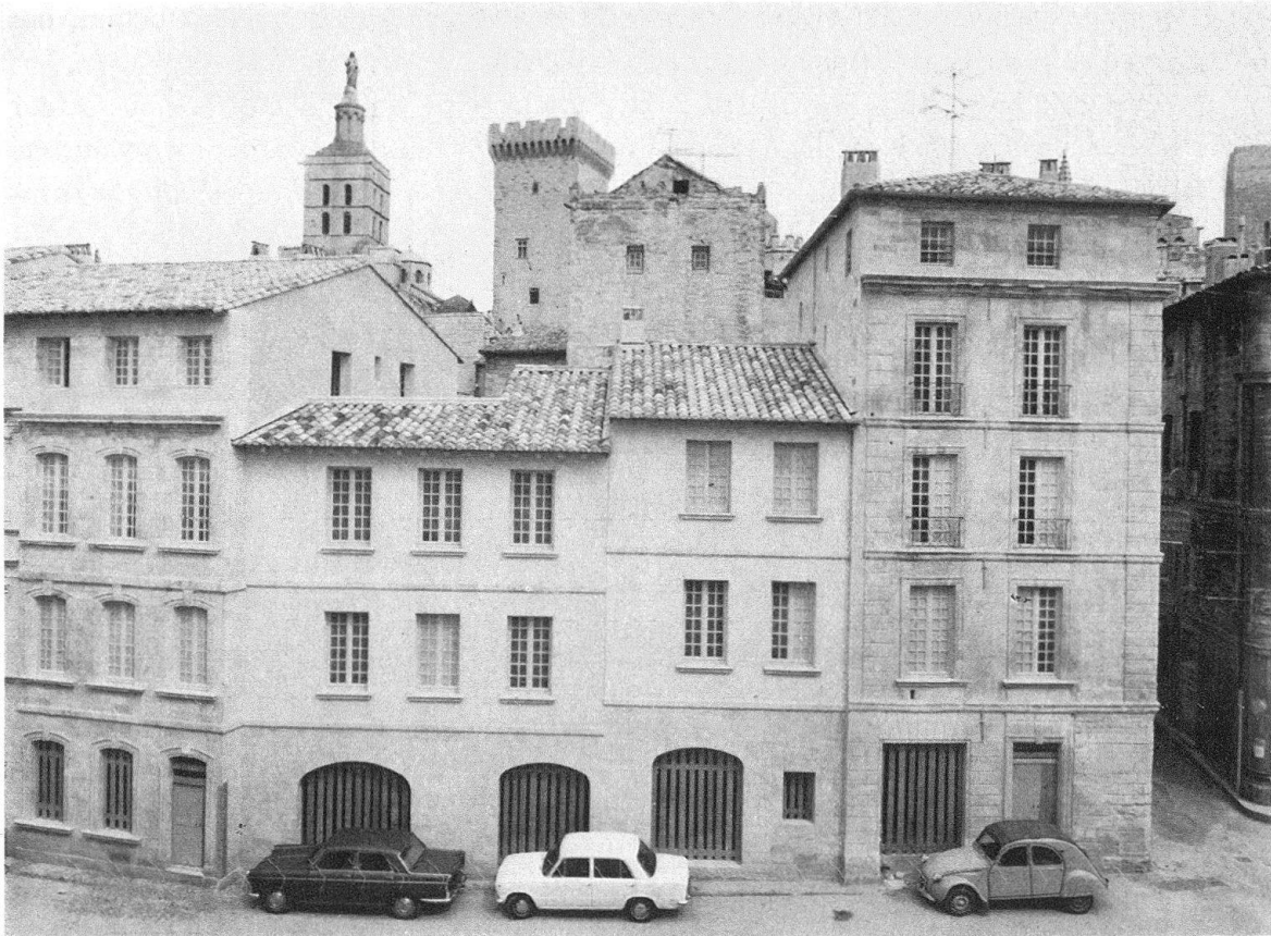
Avignon. Quartier de La Balance. Immeubles restaurés
