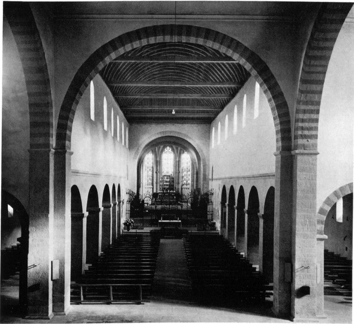
Abb. 2. Marienmünster Reichenau-Mittelzell. Ansicht vom Bernobau aus gegen das Schiff mit dem offenen Dachstuhl und den spätgotischen Chor
