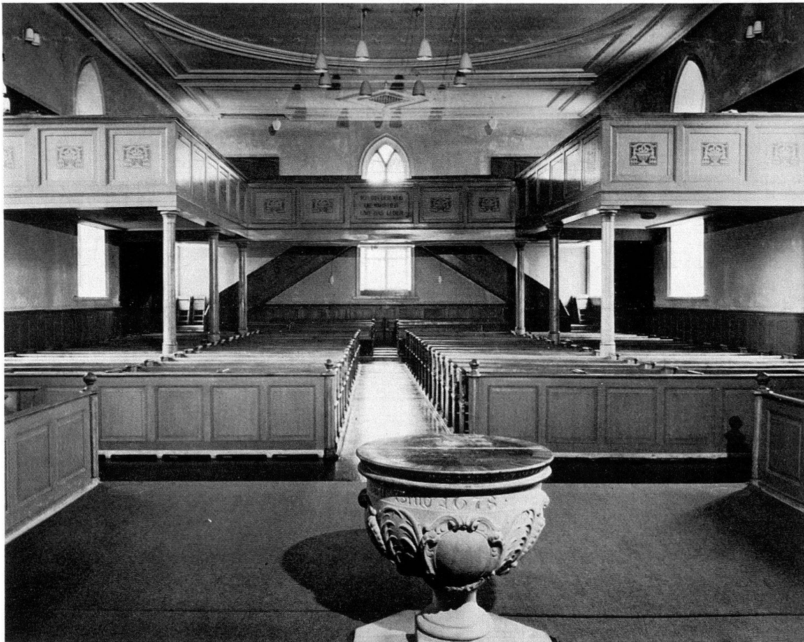
Bülach, reformierte Kirche. Kernbau von 1508–1514, umgestaltet 1870/71 in einer bezeichnenden Mischung von Klassizismus und Neugotik. Im Vordergrund der Taufstein von 1678. Aufnahme vor der Neugestaltung 1969/70
