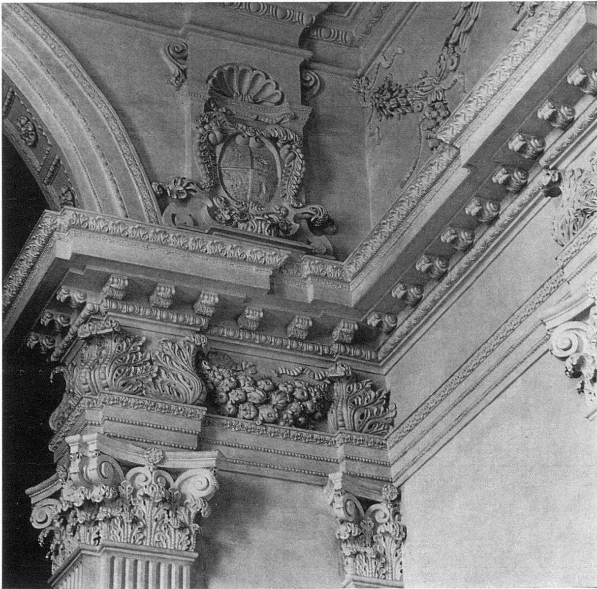
Fig. 4. Arc de triomphe vu depuis la nef, stuc de Michael Schmutzer, photo après la restauration
