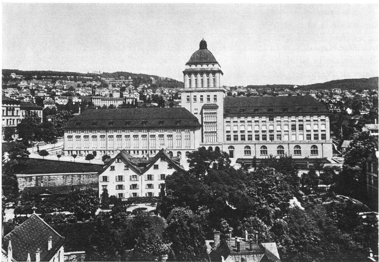
Universität Zürich, Kollegiengebäude. Erbaut 1911–1914 nach Plänen von Karl Moser. Gesamtansicht von Westen (1916)
