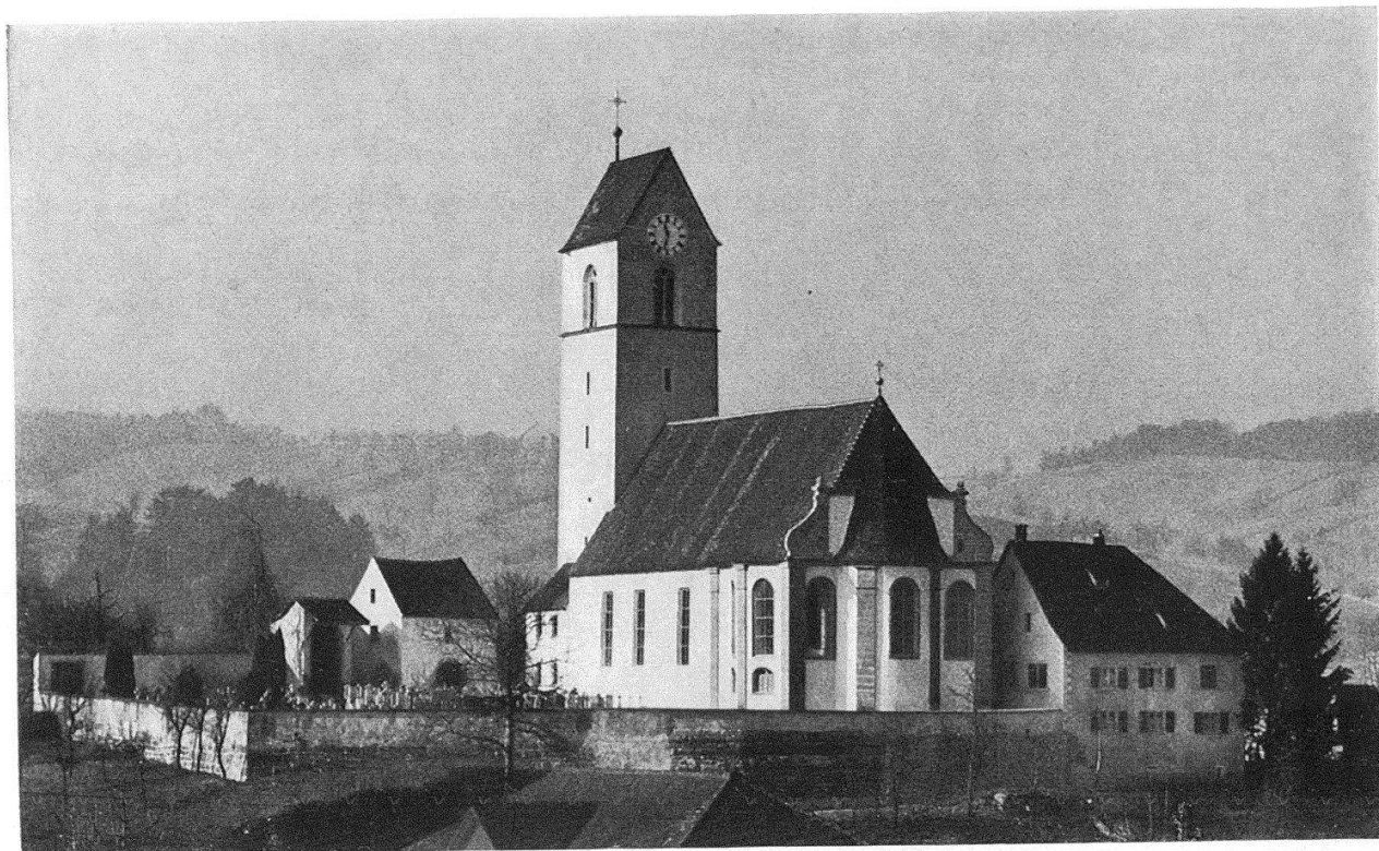
Herznach. Pfarrkirche. Ansicht von Südosten
