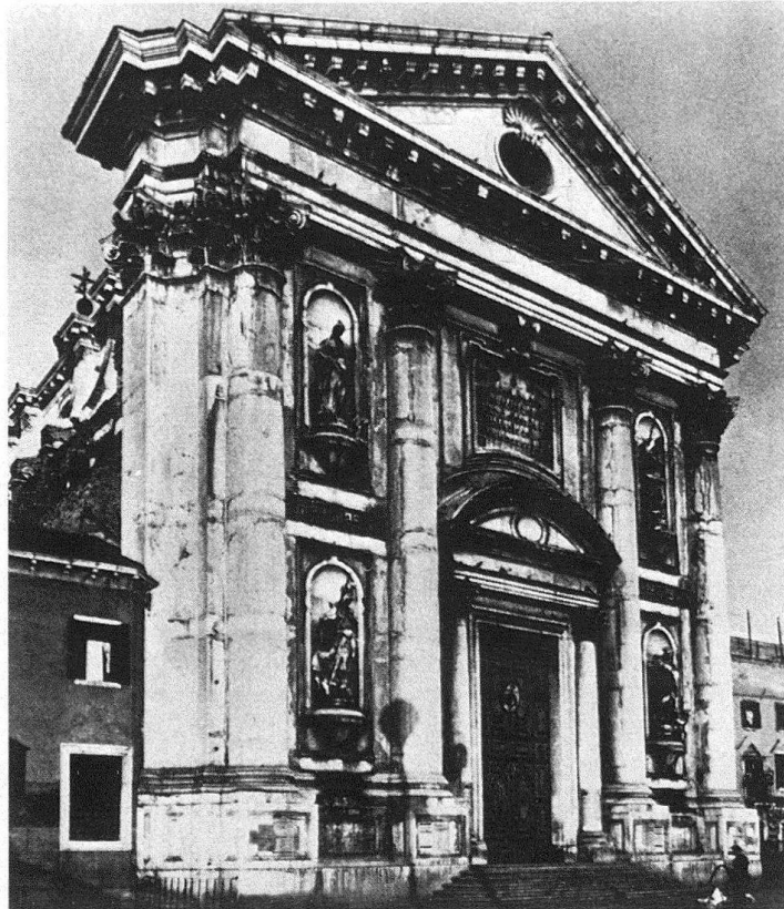
Abb. 2. Giorgio Massari, Fassade der Chiesa dei Gesuati, Venedig, 1724 ff.
