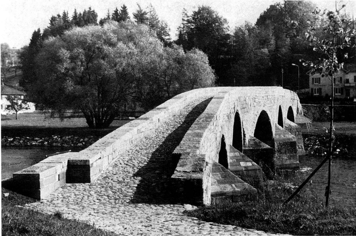
Bischofszell. Die mittelalterliche Thurbrücke (1478) nach der vollständigen Restaurierung.
