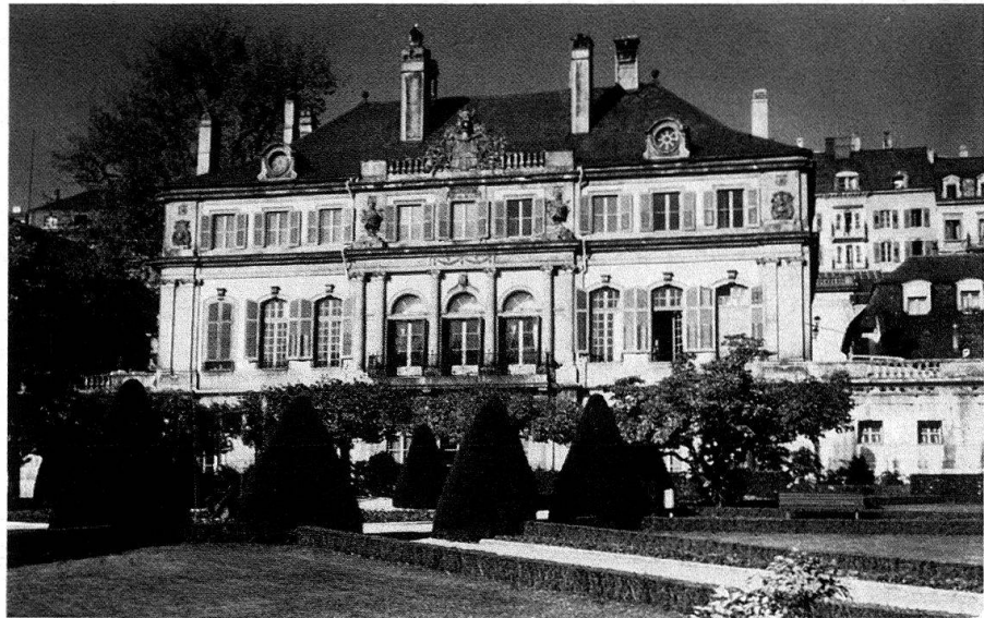
Neuchâtel. Hôtel DuPeyrou de Erasme Ritter, 1765 à 1770/71. Avant la restauration
