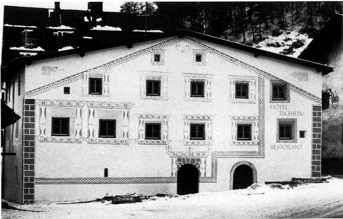
Müstair GR. Hotel Hirschen vor und nach der Restaurierung. Das den Platz Grond massgeblich prägende Gebäude ist im ersten Drittel unseres Jahrhunderts umgebaut und mit einem turmartigen Aufbau versehen worden. Bei der Fassadenrestaurierung von 1974 entdeckte man eine originale Sgraffitodekoration von 1613, welche wiederhergestellt wurde und die Rekonstruktion der ursprünglichen Fensterdisposition gestattete. Auf die ursprüngliche Dachneigung, die von der Dekoration markiert wird, konnte man aus Nutzungsgründen nicht zurückgehen. Photos: M. Burkhardt, Müstair
