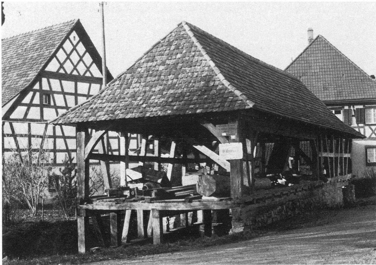
Buch, alte Säge. Restaurierter Säge-Bau; Einbau der alten Einfachgang-Säge und des rekonstruierten Wasserrades folgen
