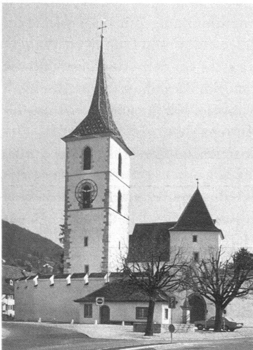
Muttenz, Arbogastkirche. Die umfangreiche Restaurierung dieser befestigten Kirche und deren grossartigen Wandbilderzyklen konnte trotz grosser technischer und finanzieller Schwierigkeiten 1975 abgeschlossen werden
