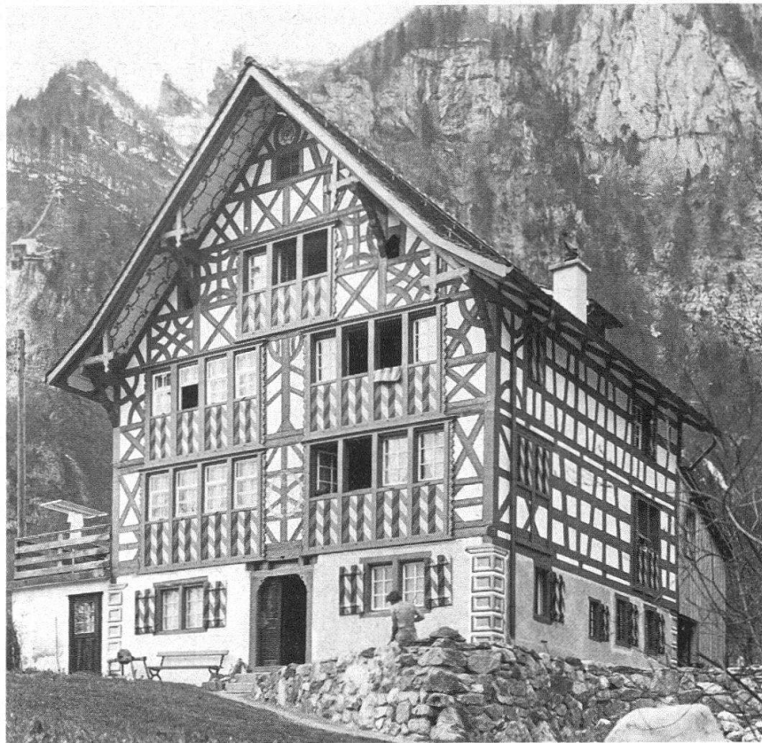
Netstal GL. Das 1728 erbaute Stähli-Haus, dessen Restaurierung 1974 abgeschlossen werden konnte, steht für eine ganze Reihe historischer Wohnbauten im Glarnerland, die mit Hilfe der eidgenössischen Denkmalpflege instand gesetzt werden. Oben vor der Restaurierung, rechts nach der Restaurierung
