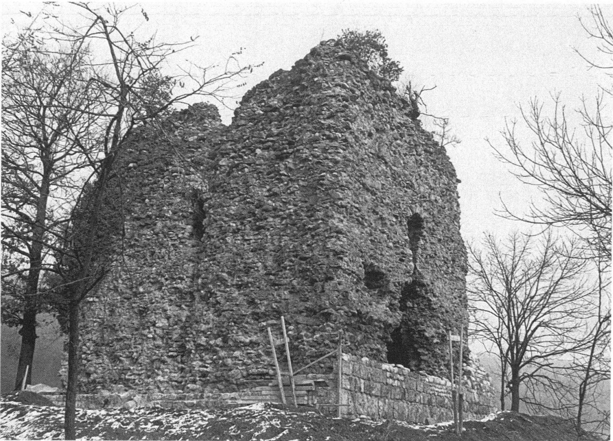
Freienstein-Teufen. Burgruine. Stand der Arbeiten Ende November 1975 bei der Südwestecke
