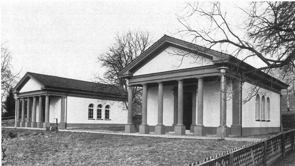
Zofingen. Restaurierte klassizistische Schutzhäuser von 1830/31 über den neukonservierten Mosaikböden einer römischen Villa aus dem 2. Jahrhundert n. Chr.
