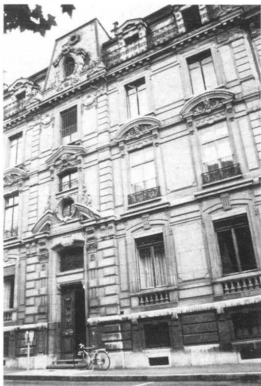
6 cours des Bastions: Les trois pièces de réception en enfilade donnant sur un petit parterre à la française ainsi que les cuisines rejetées au sous-sol procurent à cet appartement les mêmes avantages qu'un hôtel particulier
