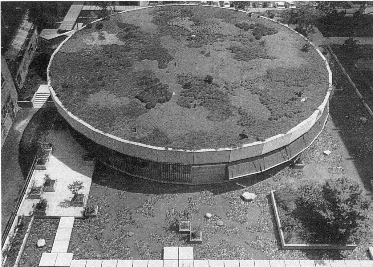
Dachgarten auf der Kantine der Ciba-Geigy AG, Basel, angelegt 1972
