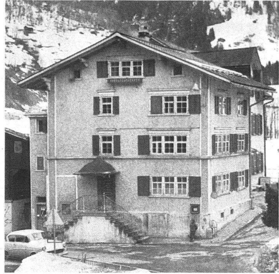
Elm. 1894 gab man dem Pfarrhaus das Aussehen eines einfachen, gemauerten Wohnhauses, indem man es verputzte und Fensterverdachungen und Klappläden anbrachte. Wie steif und gewöhnlich sah es doch aus!
