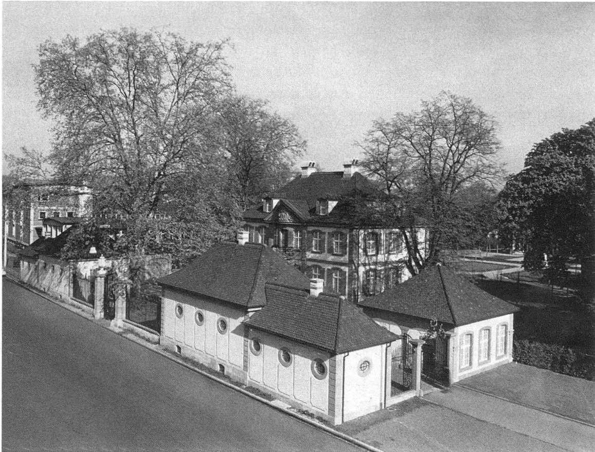
Klein-Basel. Die 1745/46 als privater Landsitz erbaute «Sandgrube» wurde 1957/1959 integral restauriert und birgt seither das Kantonale Lehrerseminar. Die Gesamtanlage von Westen
