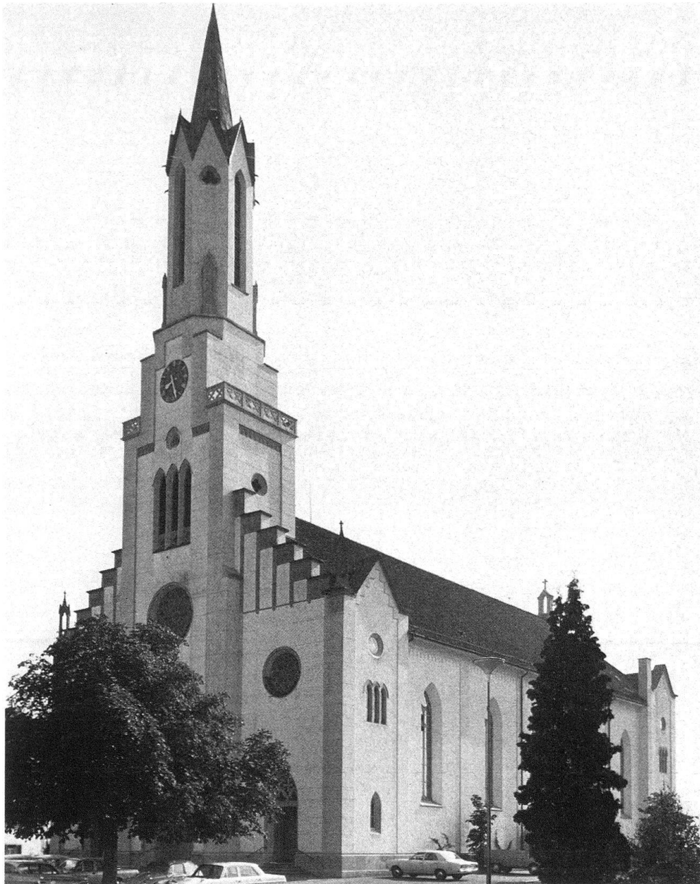
Leuggern AG. Pfarrkirche, erbaut 1851–1853 nach Plänen von Caspar Joseph Jeuch. – Links: das Innere mit der Orgelempore (vor der Restaurierung); rechts: die Hauptfassade mit dem charakteristischen monumentalen neogotischen Turm
