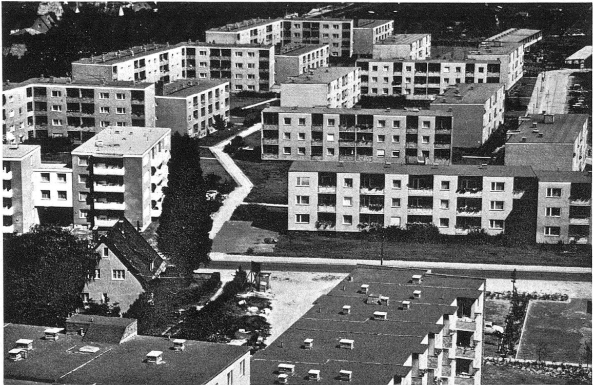
391. Louise-Schroeder-Siedlung I, 1958–61, Aufblick
