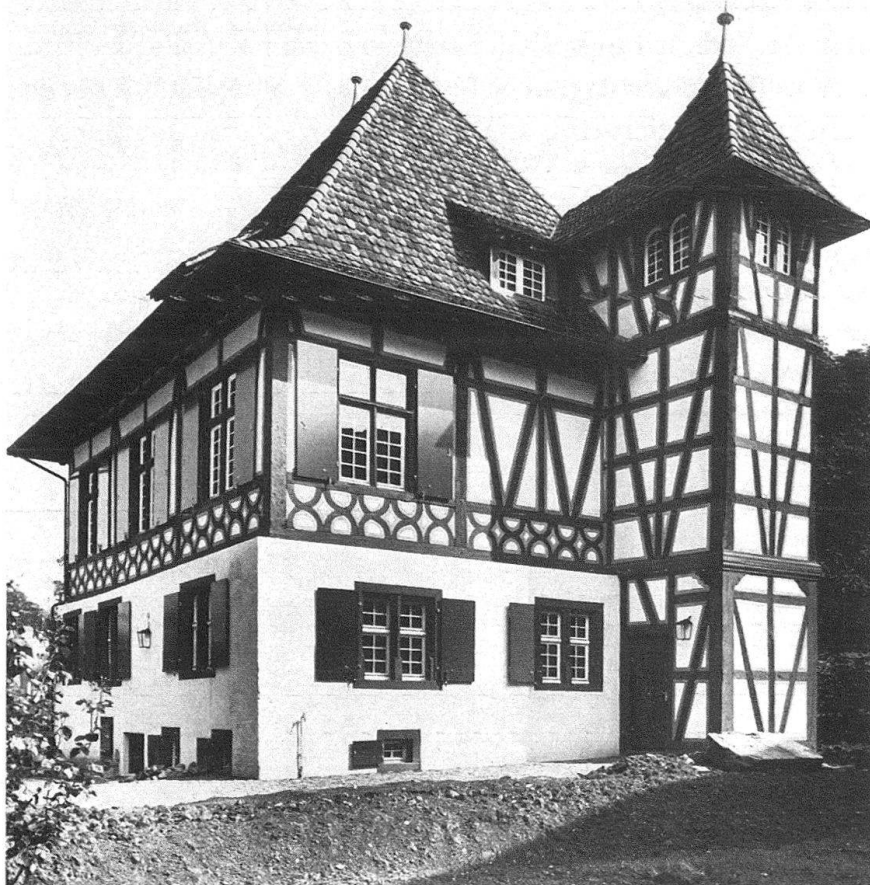
Basel. Das vollständig durchrestaurierte Thomas-Platter-Haus (Gundeldingerstrasse 280)
