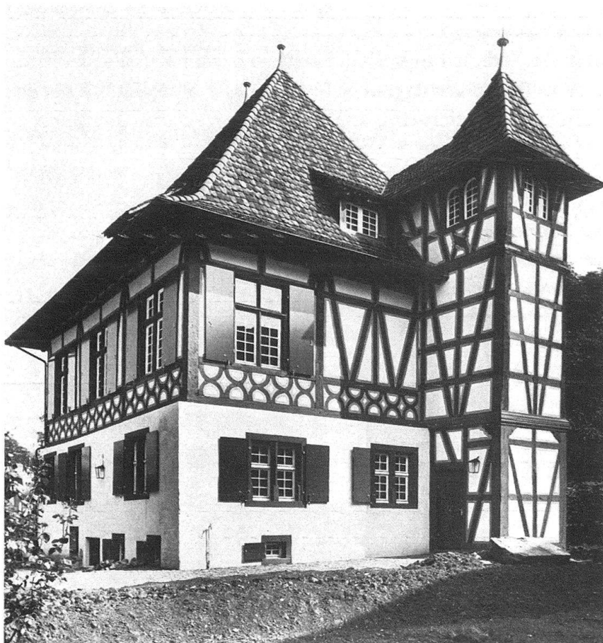
Basel. Das vollständig durchrestaurierte Thomas-Platter-Haus (Gundeldingerstrasse 280)
