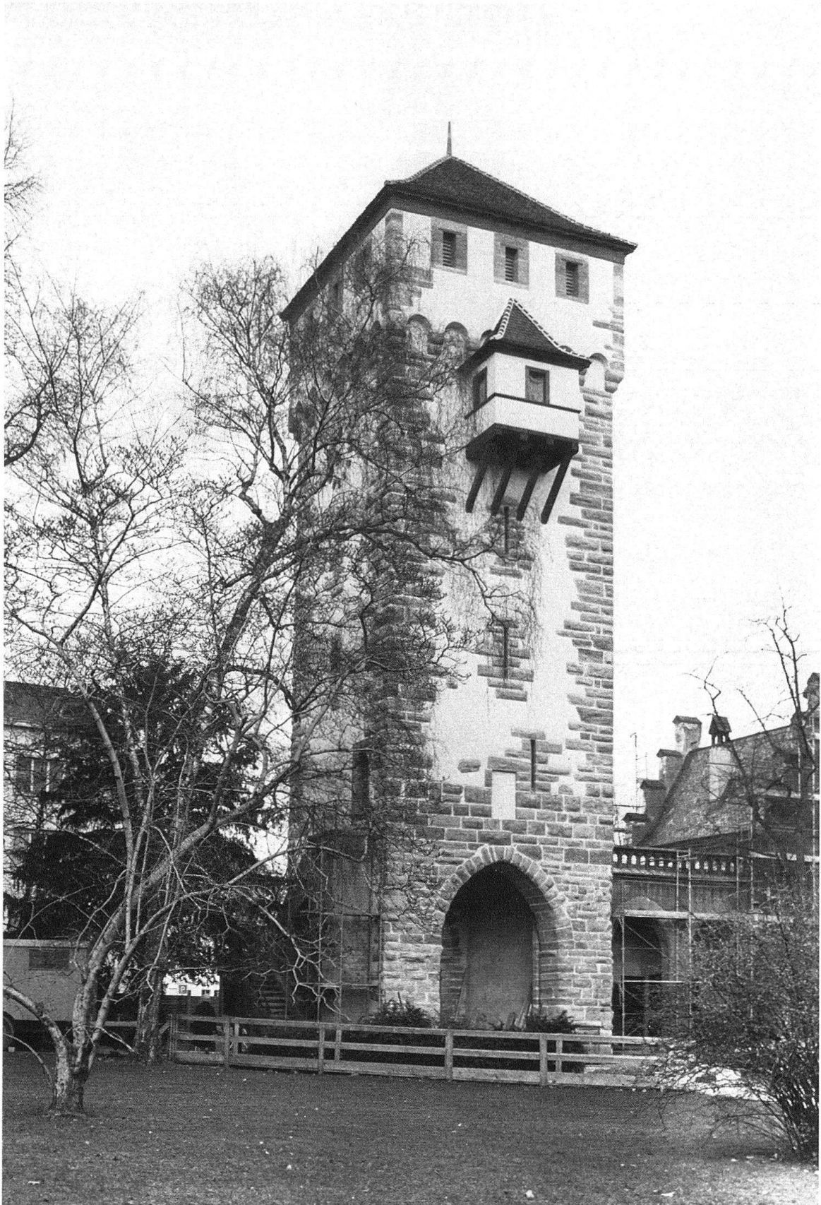
Basel. Das restaurierte Albantor, Zustand Februar 1977
