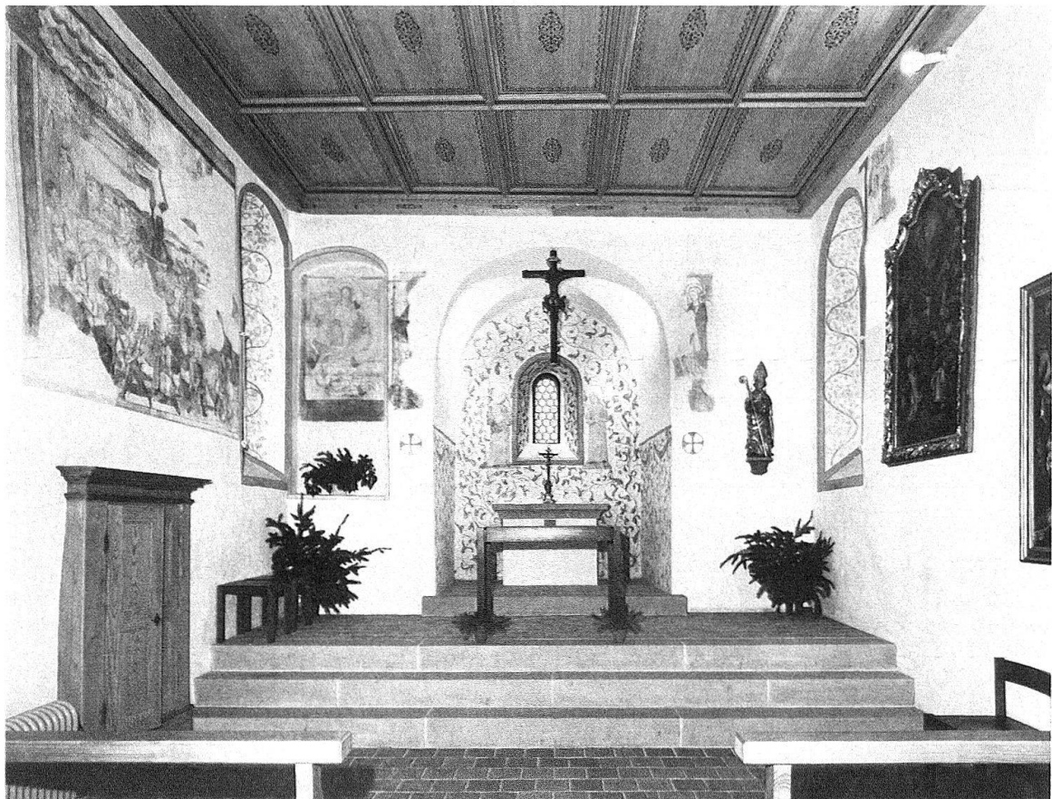
Abb. 6. St. Niklaus auf dem Berg bei Willisau. Inneres nach der Restaurierung. Das zugemauerte Chorthauptfenster wurde wieder geöffnet und der stichbogige Gipsplafond durch eine Holzdecke ersetzt
