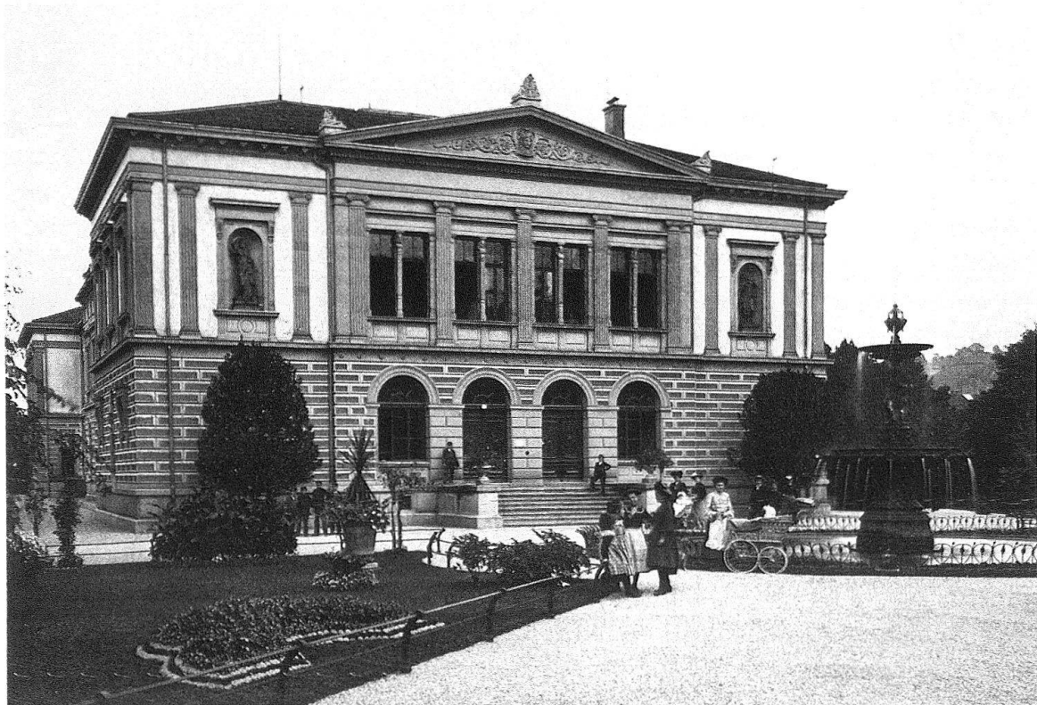
St. Gallen. Das alte Museum, 1877 von Christian Kunkler erbaut. Umbau oder Abbruch? Das Rennen steht noch offen. Aufnahme um 1900
