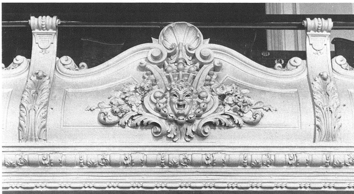
Fig. 10. Morges. Casino, détail de la galerie
